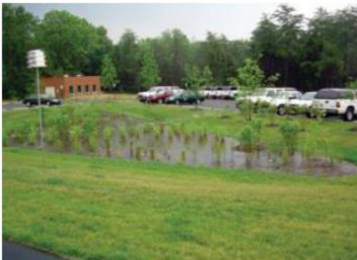
Joonis 3.23. Biopuhver (Infragate Eesti AS, 2016).
