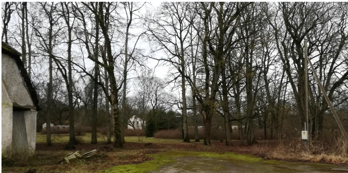
Foto 25. Madalpinge õhuliini tugipost ja elektrikilp uuritud pargi ala idaservas ajaloolise mõisa aida läheduses. 2020. Foto: Toomas Pöld
